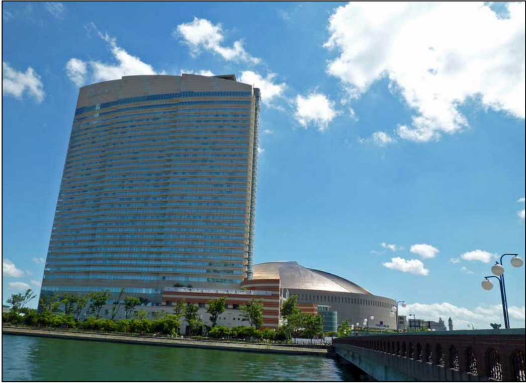
【シーホーク&ヤフードーム】
